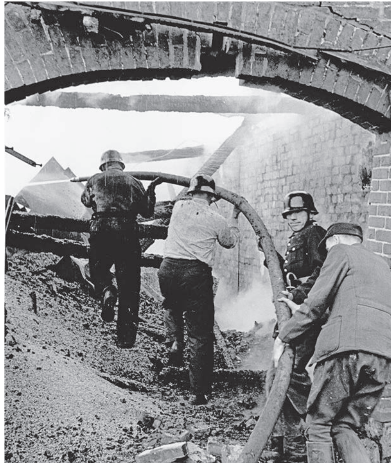
Bei diesem Scheunenbrand in Röbel 1953 hatten die Feuerwehrleute Glück. Wenig später stürzte der Torbogen ein - als niemand mehr darunter stand.
